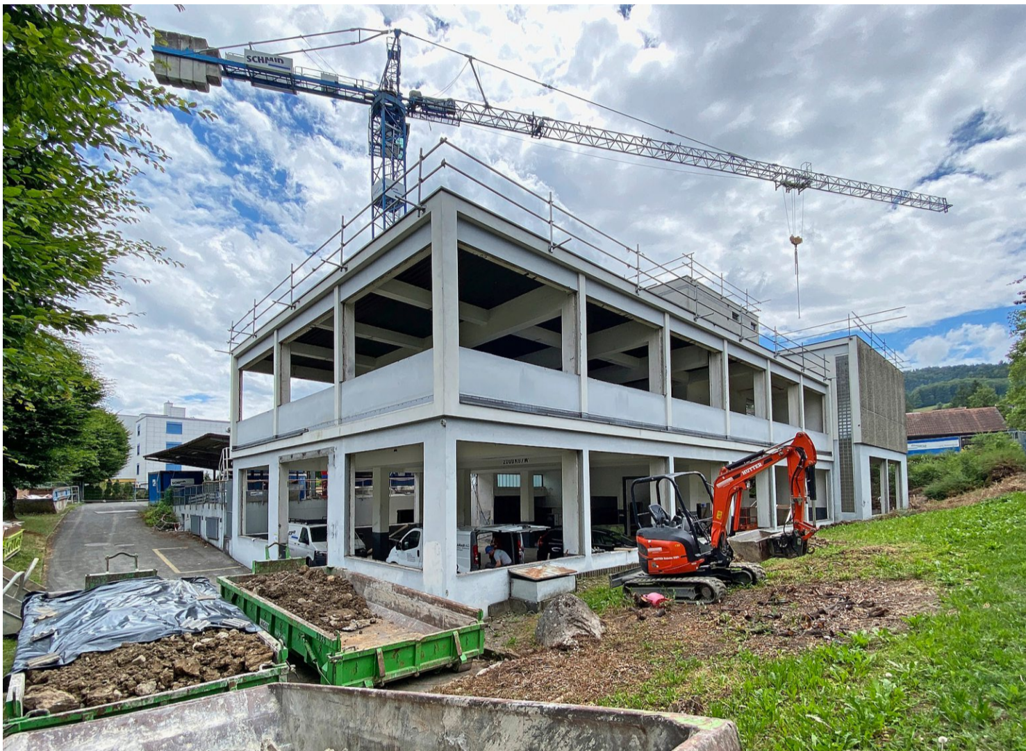
Das Gebäude der ehemaligen Metallfirma Emil Meier in Adliswil wird zurzeit entkernt und umgebaut. Foto: Sabine Rock
