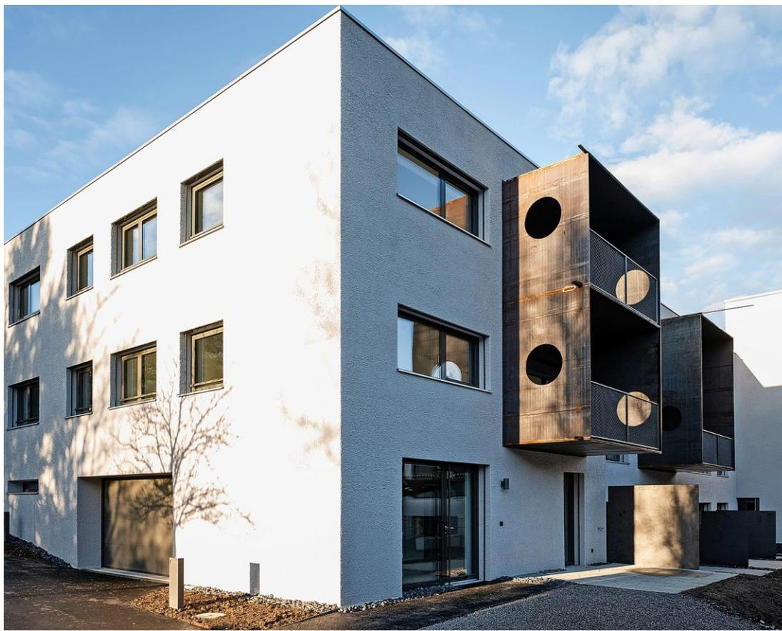
Gebäude von aussen: Für die Loggien wurden Metallplatten aus dem Strassenbau verwendet. Fotos: Manuela Matt
